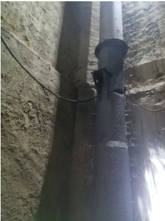
FOTO 3. Quvur mahkamlash tuguni va beton devor holati.
