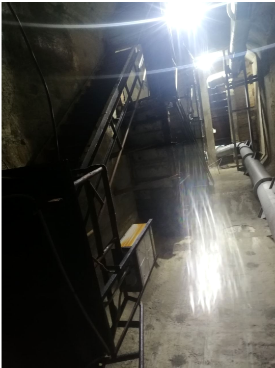
FOTO 5. Ichki shaxta, metall konstruksiya va xizmat yo'lagi.
