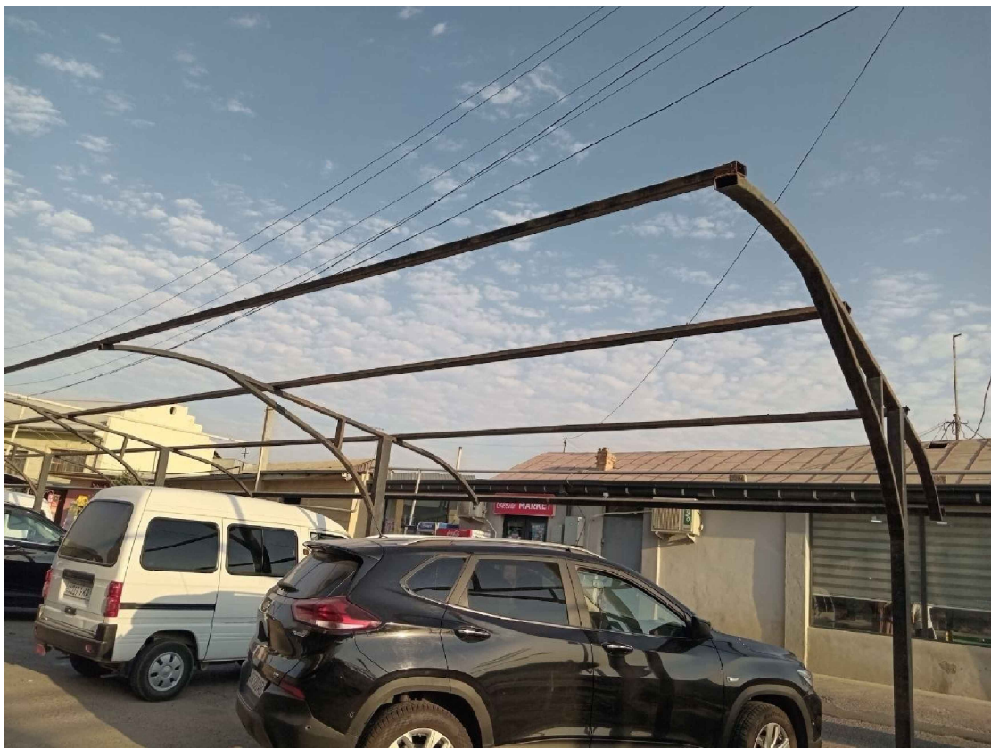
Существующее вид навеса
